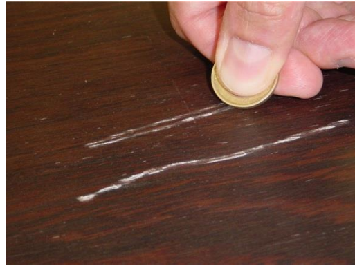
Fig. 2: Superficie con mala adherencia después del test de la moneda
